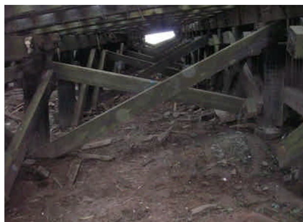
Nettoyage du dessous de la rampe de débarquement à l'Île d'Entrée (après).
