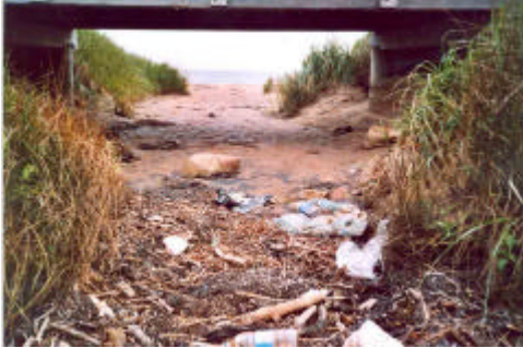
Ruisseau intermittent avant nettoyage.
